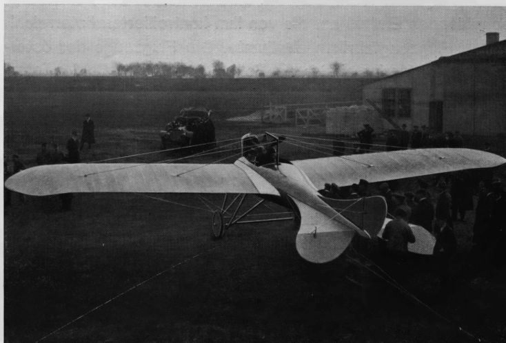
Ausführung des von Ernst Heinkel konstruierten Albatros-Eindeckers mit Stirnkühler und nebeneinanderliegenden Sitzen. 1913
