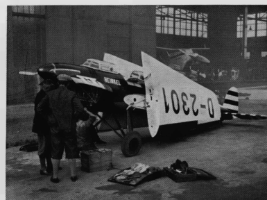
Heinkel Sportflugzeug He 64 für den Internationalen Rundflug, mit zurückgeklappten Flächen 1932
